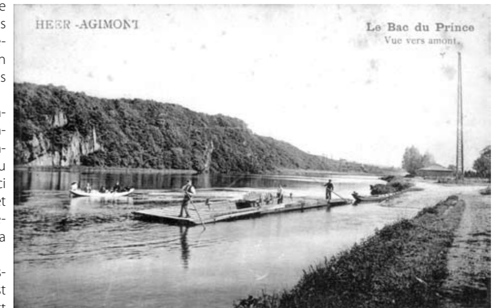
Le passage du Bac-du-Prince à Heer-Agimont, au début du XX e siècle. A droite, le pylône portant le câble qui traverse le fleuve. Tout près du sommet de ce mat, on distingue le chariot auquel s'amarre le grand bac.
